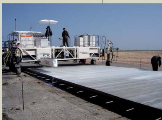
Dettaglio del getto con tecnologia slip form orizzontale prevista per la costruzione della pista di atterraggio
