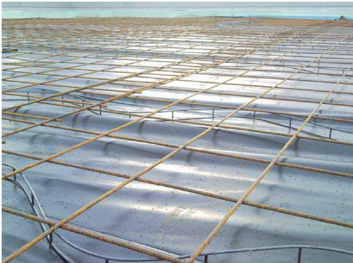
Il cantiere di Mestre (VE)
