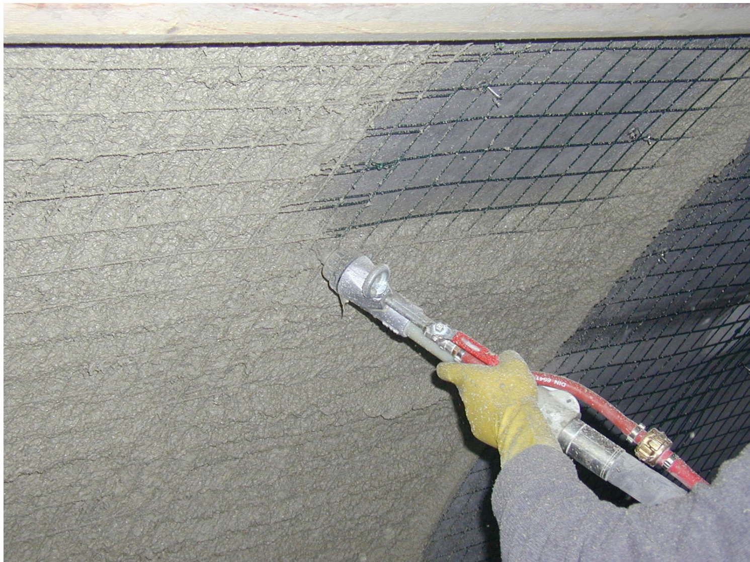
Obiettivo sicurezza “antincendio” in galleria: applicazione dell’intonaco protettivo Aeternum Fire
