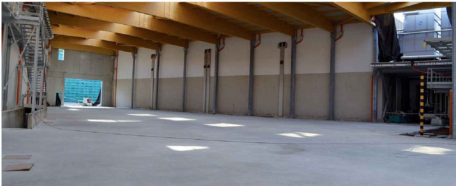
Un caso costruttivo da manuale: lo stabilimento Melinda a Cunevo (Trento)
