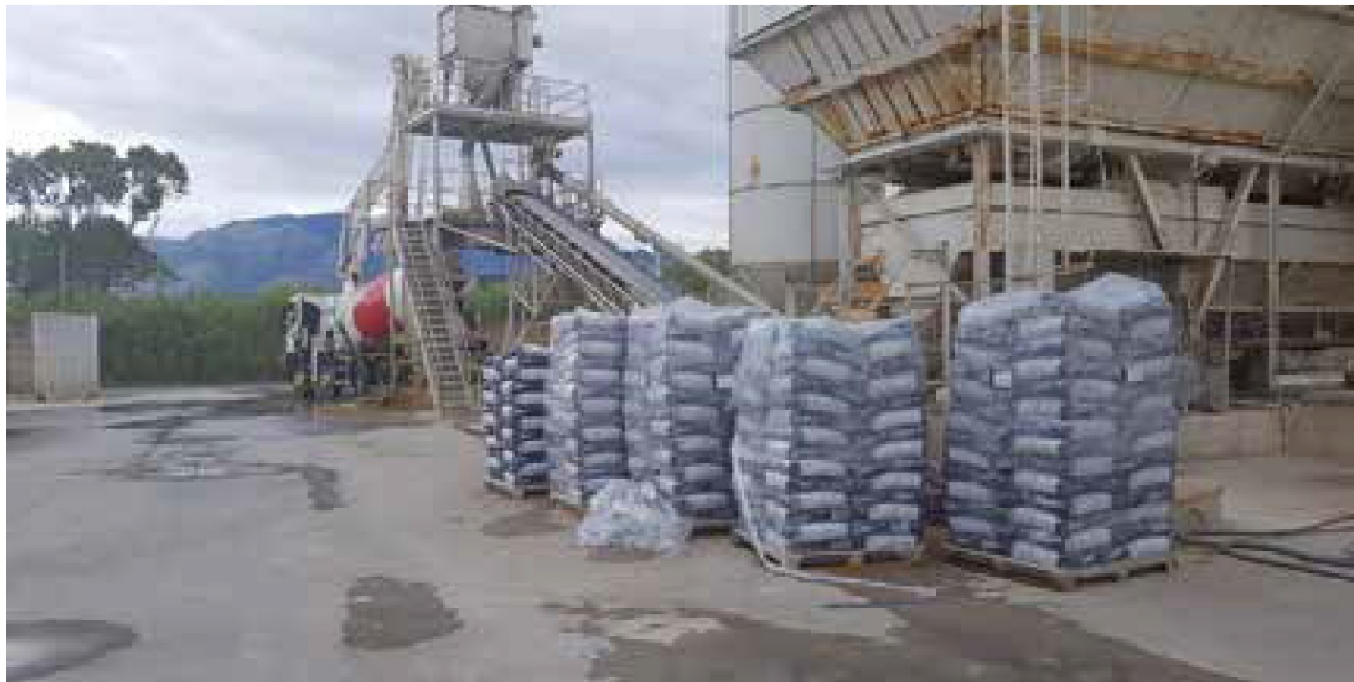
Il compound Tekna Chem nell'impianto di premiscelamento
