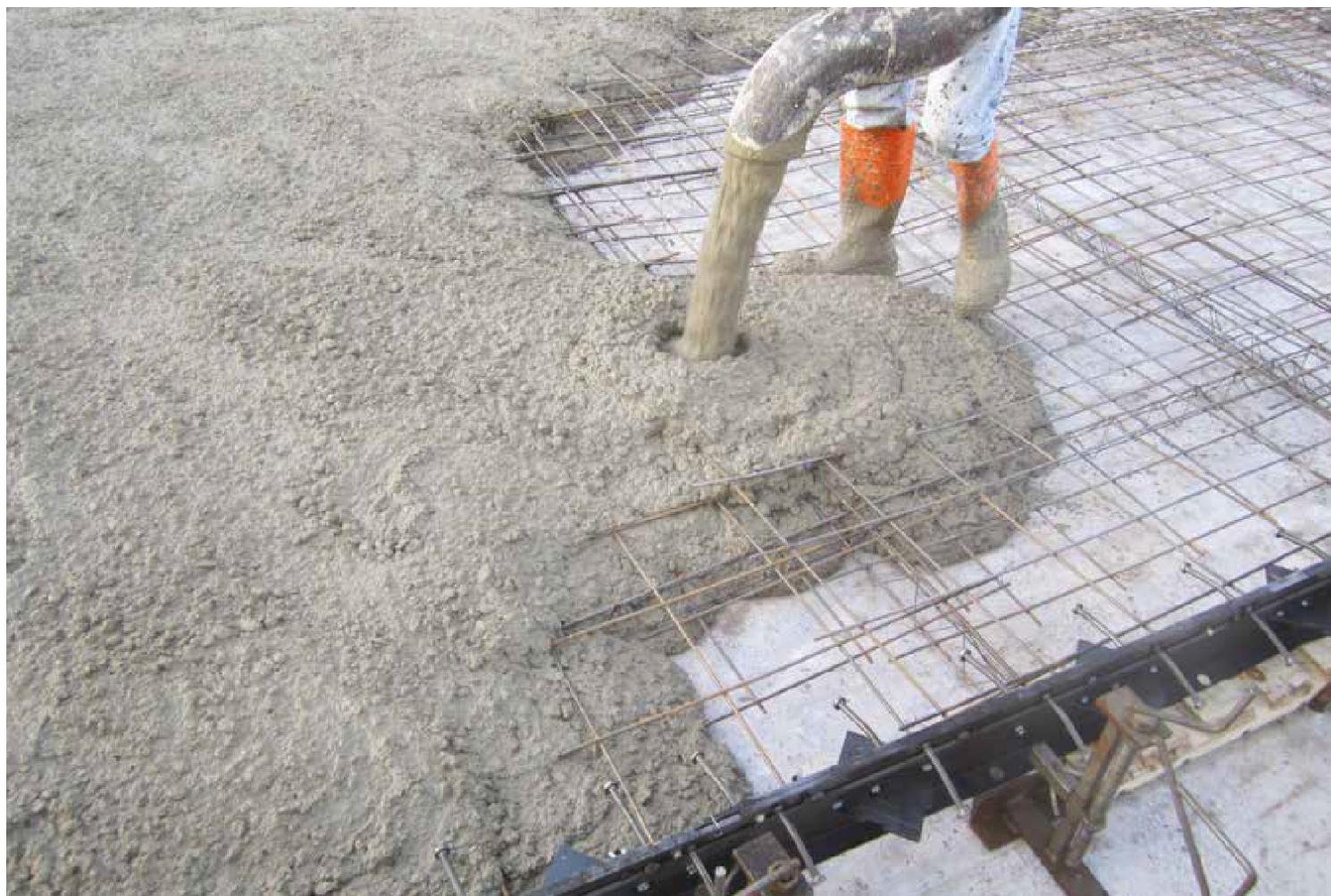
Calcestruzzo gettato in opera
