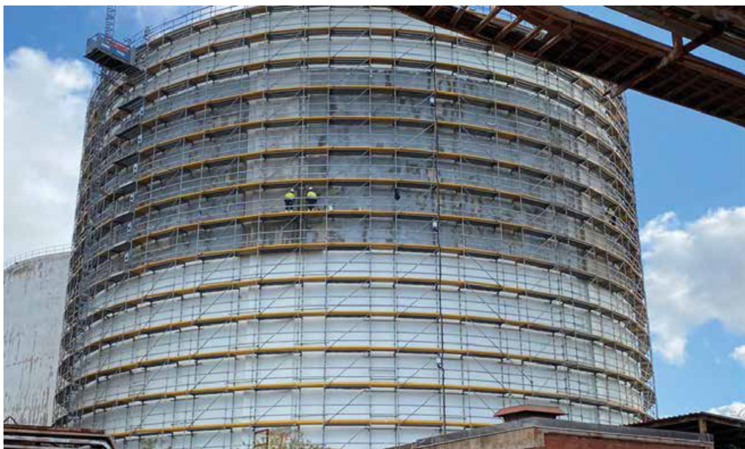
Silos con intonaco a elevate performance realizzato con malte Grautek a Portovesme in Sardegna
