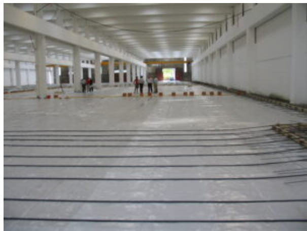
Posa dei cavi nello stabilimento TENAX, fase iniziale
